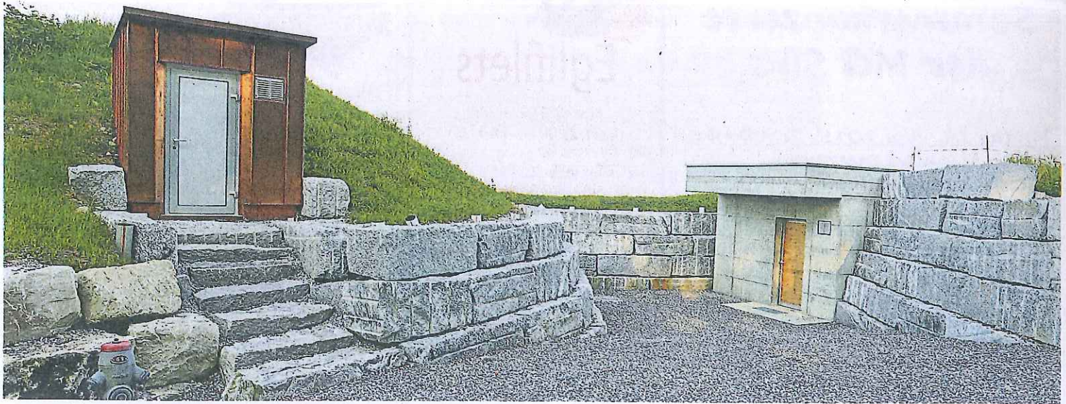
Der neu gestaltete Eingangsbereich zum zusätzlichen Reservoir Than 3 (rechts) mit 500 Kubikmeter Fassungsvermögen und zum Than 2.
